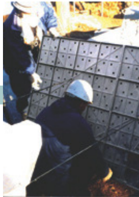
2 KCパネルの取付け
