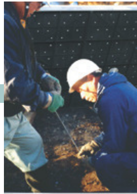
3 KCパネル固定ナットの取付け
