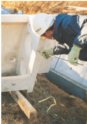
1 セパレーターの取付け
