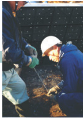
3 KCパネル固定ナットの取付け
