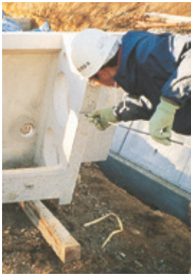
1 セパレーターの取付け
