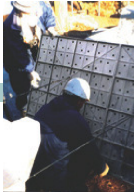
2 KCパネルの取付け
