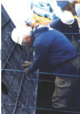
5] KCパネルの固定
