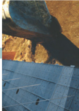
6] 裏込材料の投入
