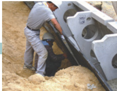
2 KCパネルの固定
