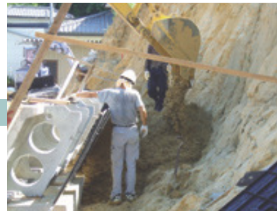
3 裏込材料の投入
