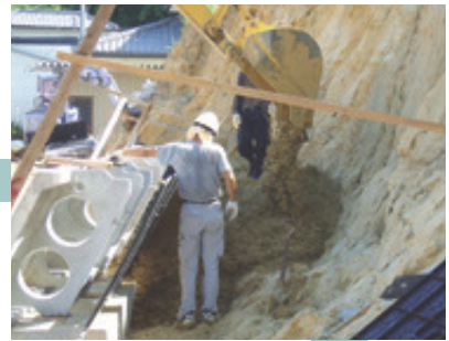
3 裏込材料の投入
