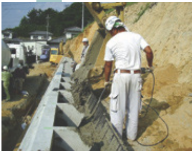
4 胴込コンクリートの打設
