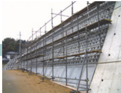
5 据付け完了及び足場設置
