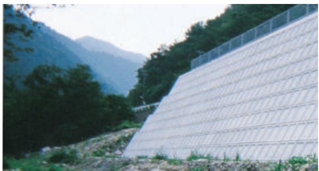
山間部の路側での使用例 [壁前面は河川、天端は道路]
