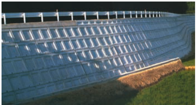
天端に構造物を付けた使用例 [ガードレールを設置した場合]
