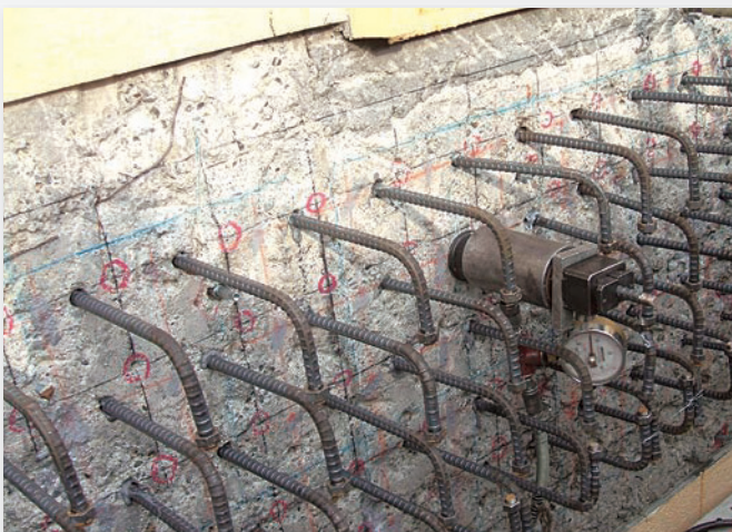
大規模な工事にも対応いたします。
