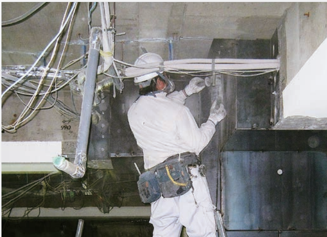
熟練のスタッフが耐震工事を担当します。
