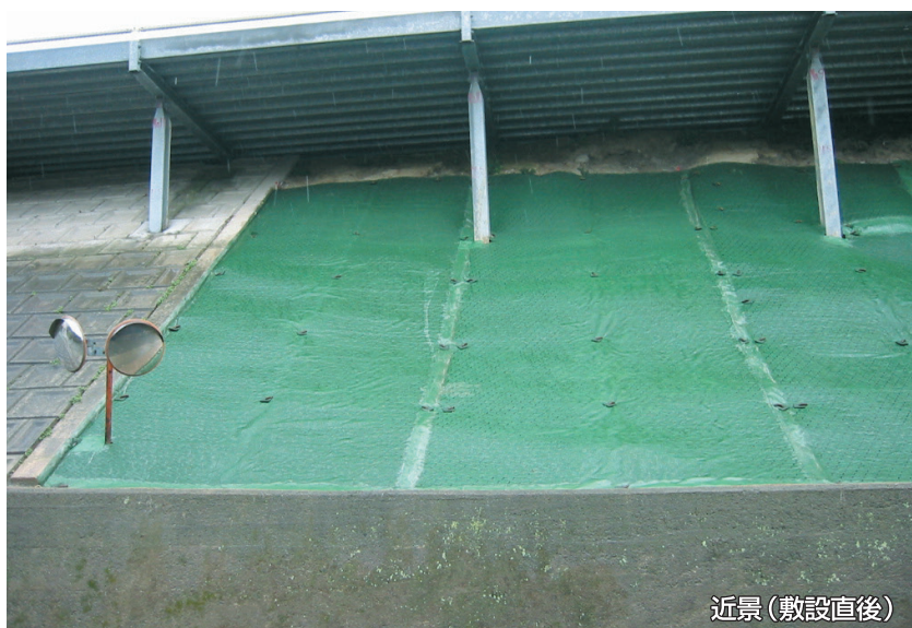
施主:福岡県宗像土木事務所 工事名:玄海宗像線局部整備工事
