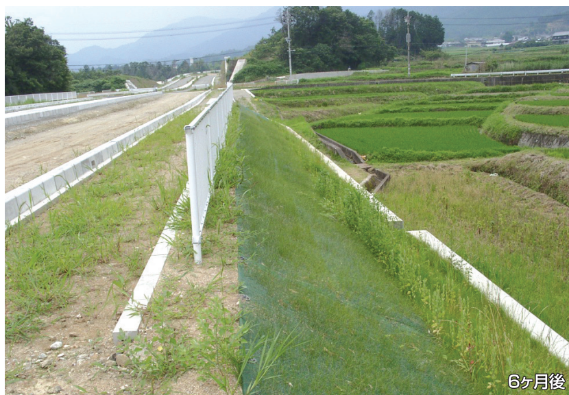
施主:奈良県五條土木事務所 工事名:地方特定道路整備工事
