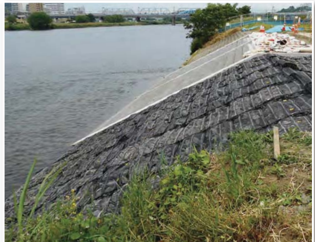
河川護岸の洗掘・侵食防止 | 工事名: H26管内改築区間(その7)工事(東京都) 施主: 国土交通省 関東地方整備局京浜河川国道事務所
