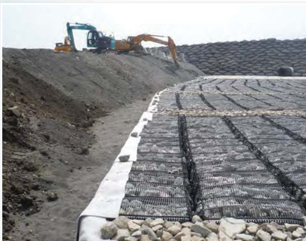
海岸の洗掘・侵食防止 | 工事名: あげぼの地区高潮堤整備工事(和歌山県) 施主: 国土交通省 整備局紀南河川国道事務所 新宮出張所
