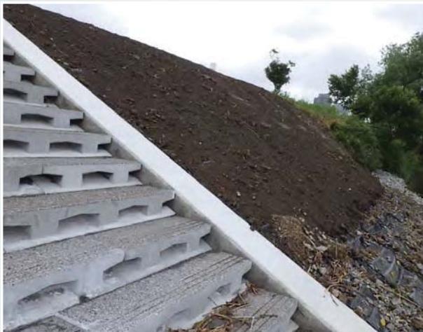
河川護岸の洗掘・侵食防止 | 工事名: H26管内改築区間(その7)工事(東京都) 施主: 国土交通省 関東地方整備局京浜河川国道事務所
