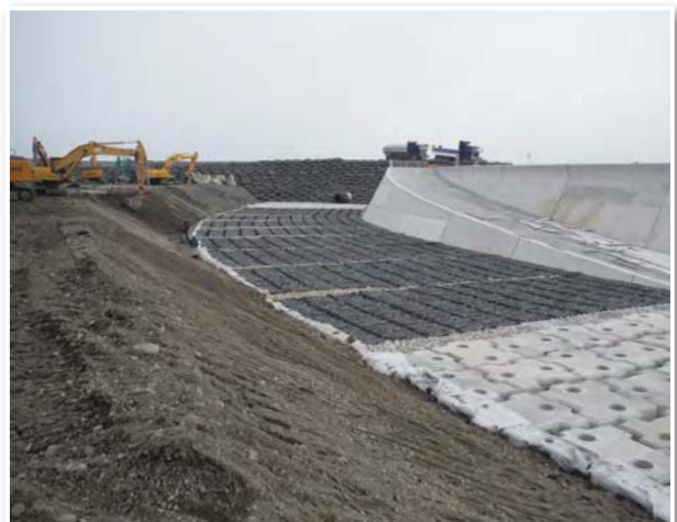
海岸の洗掘・侵食防止 | 工事名: あげぼの地区高潮堤整備工事(和歌山県) 施主: 国土交通省 整備局紀南河川国道事務所 新宮出張所
