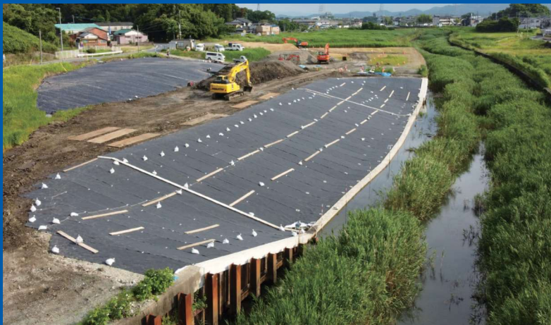
国土交通省九州地方整備局 遠賀川河川事務所 令和2年度岩崎地区矢板護岸補修工事
