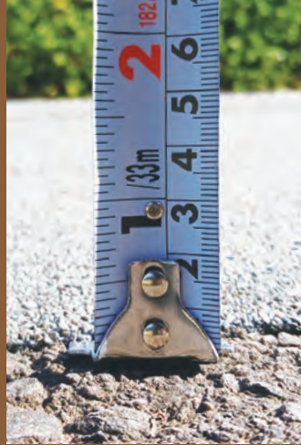
施工完了厚さ
