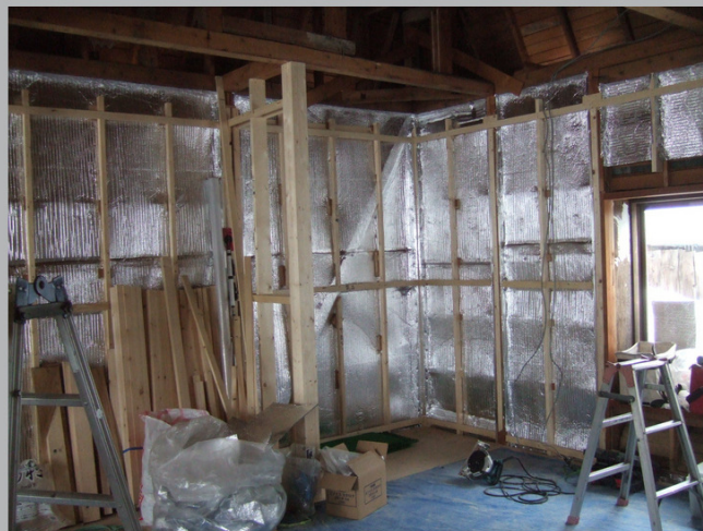
内部リフォーム：床・内壁に施工
