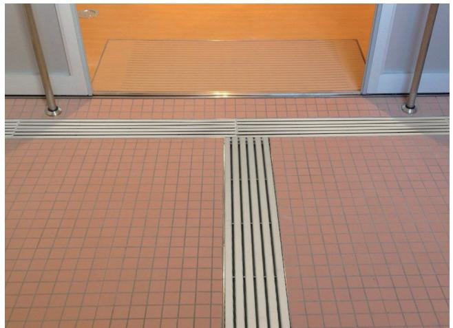
逆目形状により車椅子等の通行時に車輪が隙間に挟まる事が少なくスムーズな横断が可能です。
