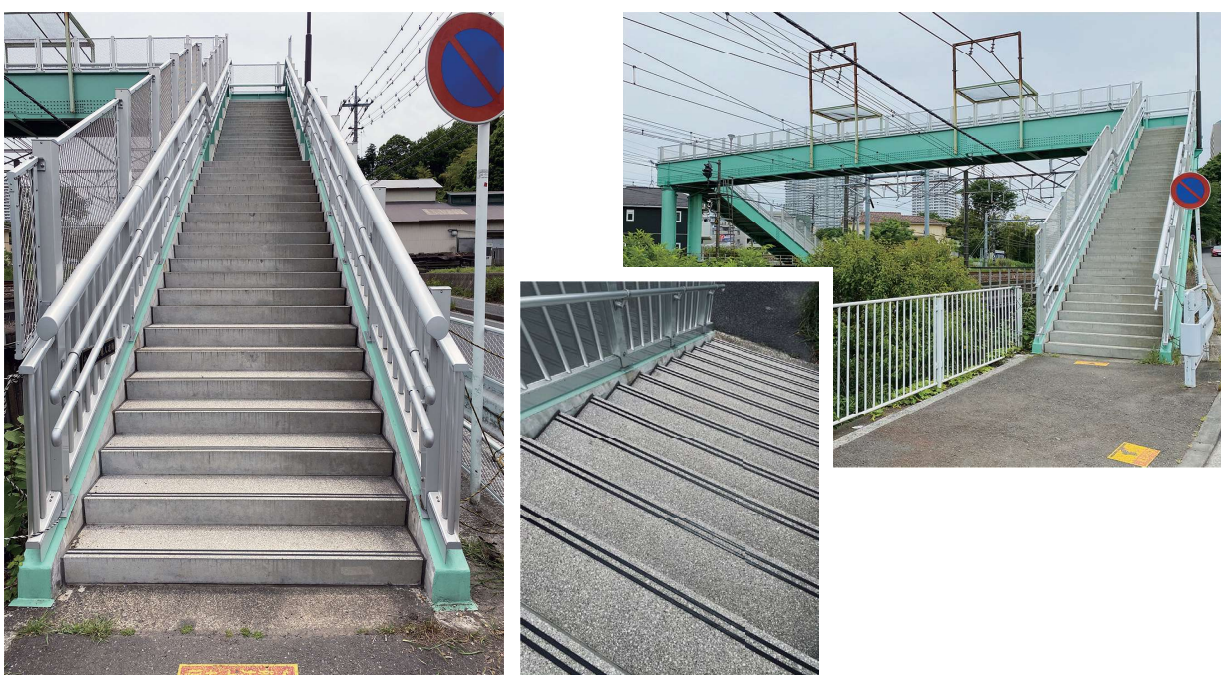
北天院跨線橋
