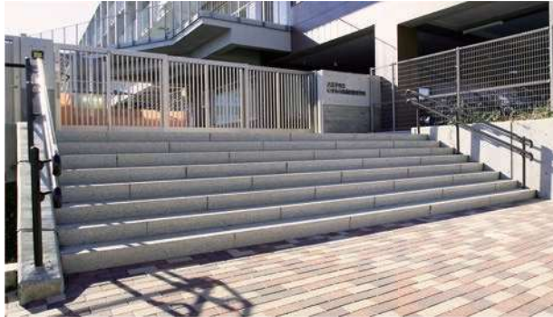
八王子市立 いずみの森小中学校
