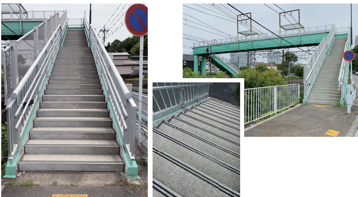
北天院跨線橋
