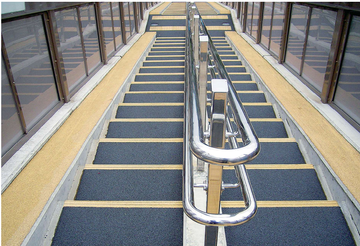
高崎市浜尻跨線橋(ゴムチップ)
