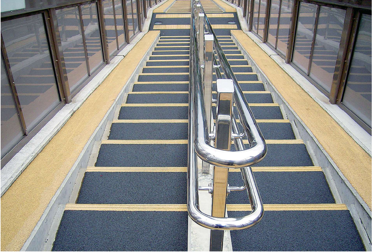
高崎市浜尻跨線橋(ゴムチップ)
