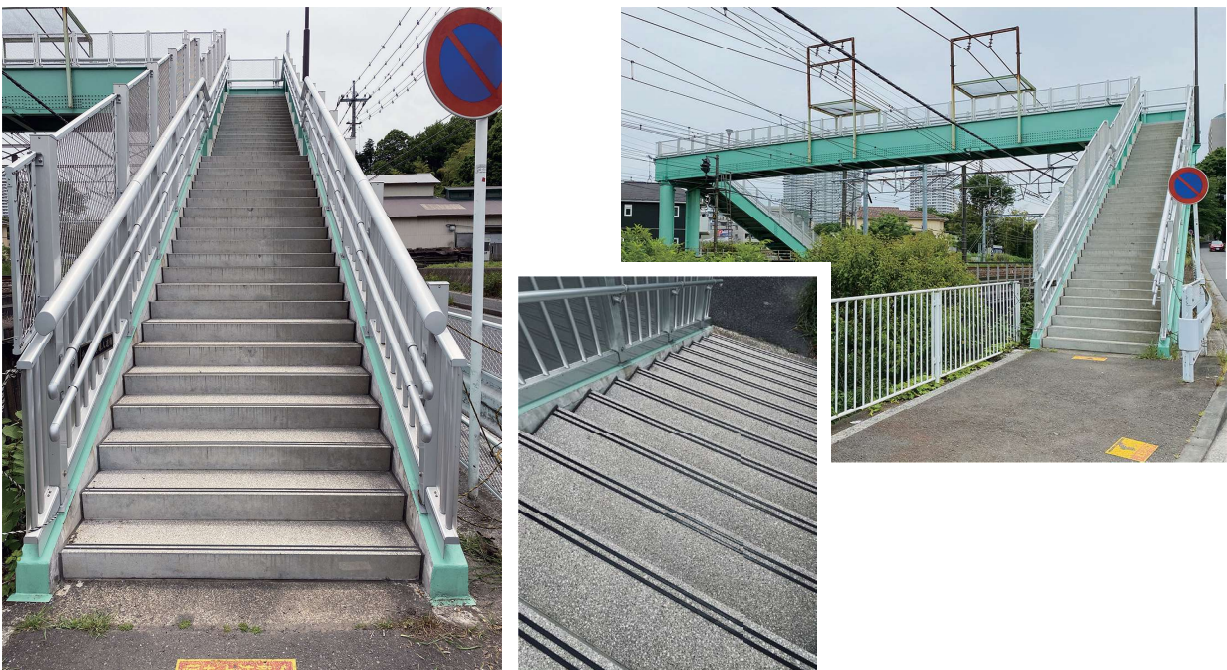
北天院跨線橋
