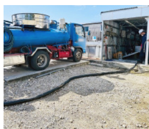
汚泥（グリストラップ）受入れ様子
