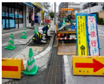
歩道補修工事
