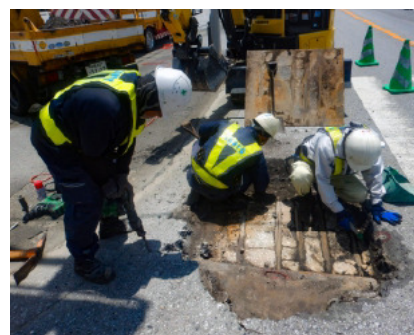
車道舗装補修工事
