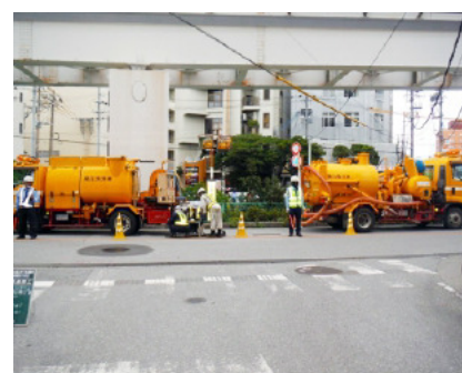
高圧洗浄車・吸引車にて清掃
