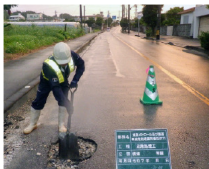
ポットホール補修工事
