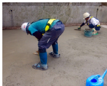
張りコンクリート工
