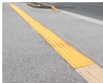
点字シート設置
