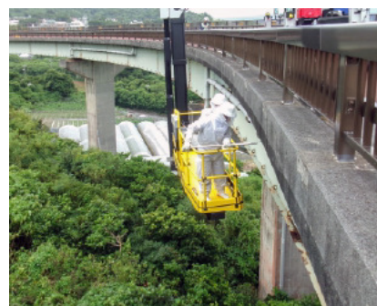
カナイ橋下ハチの巣撤去作業
