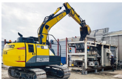
脱水ケーキ挿入中
