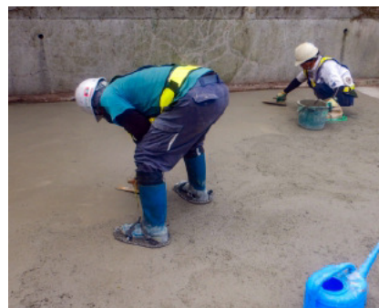
張りコンクリート工
