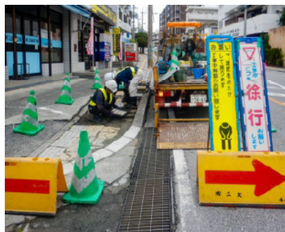
歩道補修工事
