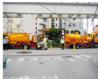
高圧洗浄車・吸引車にて清掃
