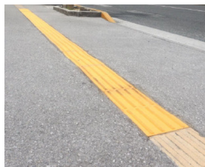
点字シート設置
