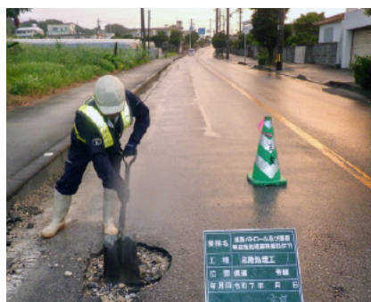
ポットホール補修工事
