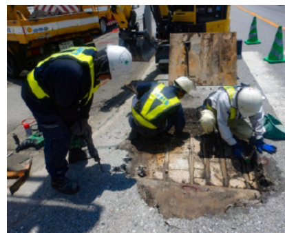
車道舗装補修工事
