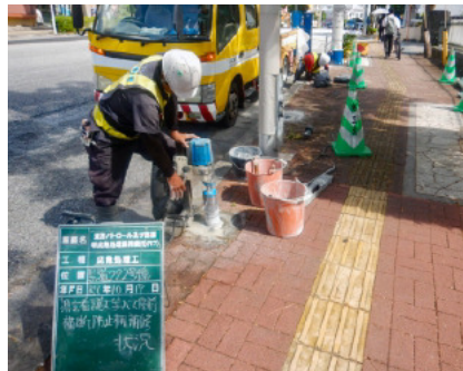
横断防止柵補修工事
