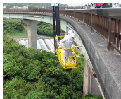
カナイ橋下ハチの巣撤去作業
