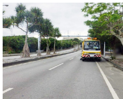
路面清掃状況
