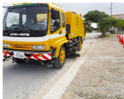
路面清掃状況
