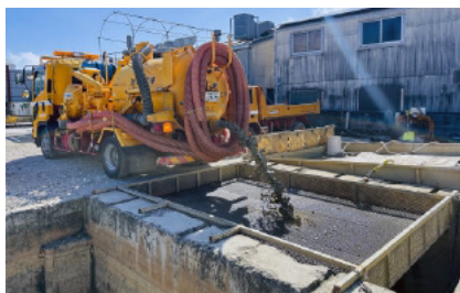
汚泥（無機）受入れ様子
