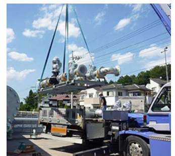
冷温水一次ポンプ搬出
