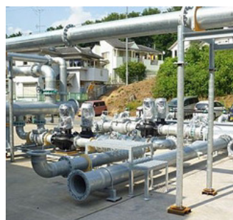
組立後 一次・冷却水ポンプ前側
