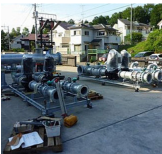
冷温水一次・冷却水ポンプユニット
