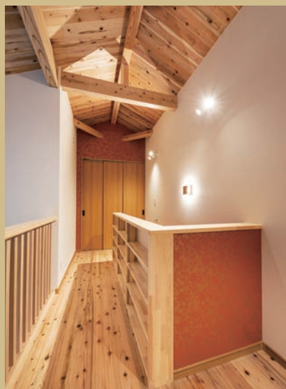
柱や梁、フロア、天井にいたるまで、すべて杉材を使用。 約1ヶ月かけて職人が造作したオープン階段もこの家の魅力。
