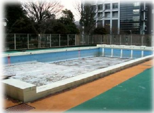
改修前・RC プール
