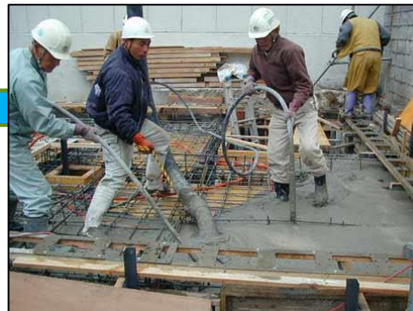
コンクリート工事業：型枠にコンクリートを 流し込む
