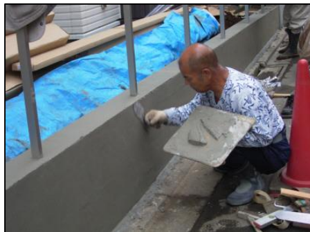
左官工事業：こて等を使って、 最終的な表面の仕上げを行う
