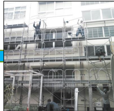
鳶工事業：作業に必要な足場、 安全設備を組み立てる
