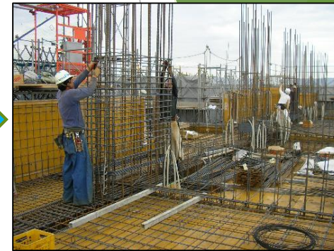
鉄筋工事業：骨組みとなる鉄筋を組み立てる
