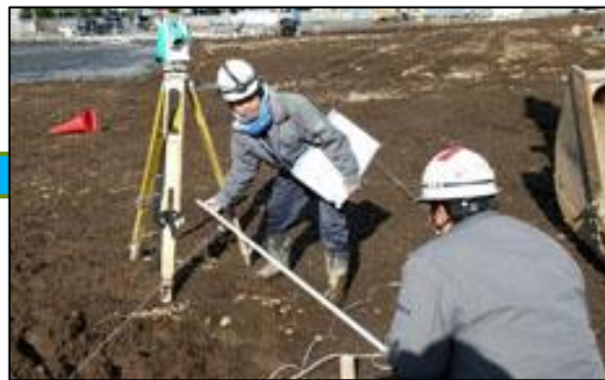
測量工事業：建物が建つ位置座標、高さ、 形状を正確に測る
