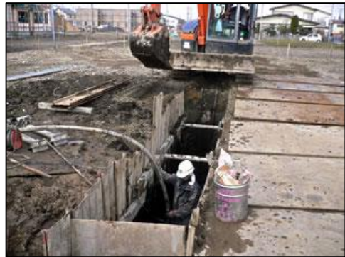
土工事業：建物が建つ土地の整備
