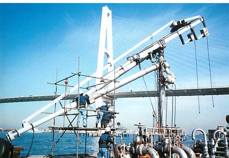
栈橋上パッキン交換工事
