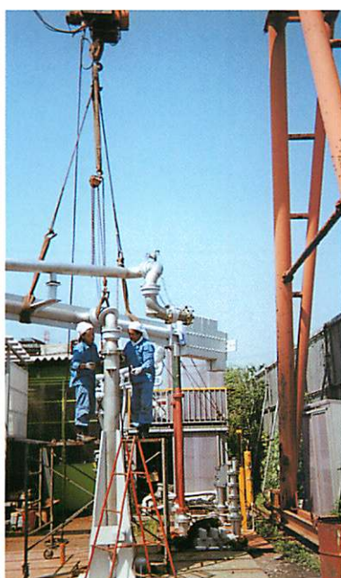
工場内でのローディングアーム仮組立
