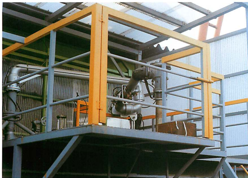
オーバーフロー防止弁のテスト装置
