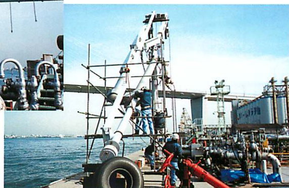
栈橋上パッキン交換工事
