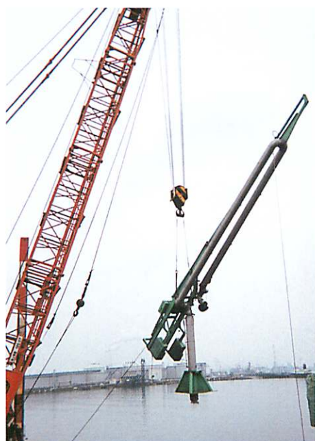
海上クレーンによる据付工事
