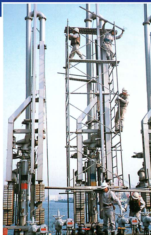
栈橋上保守整備工事
